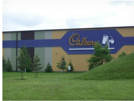
Завод по производству шоколада в г. Чудово Новгородской области
